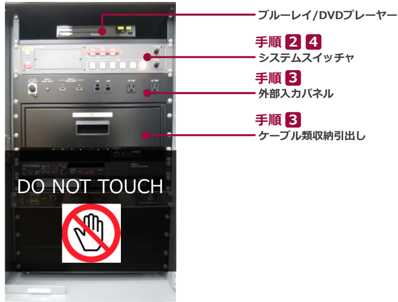
AV操作ワゴン 内部
