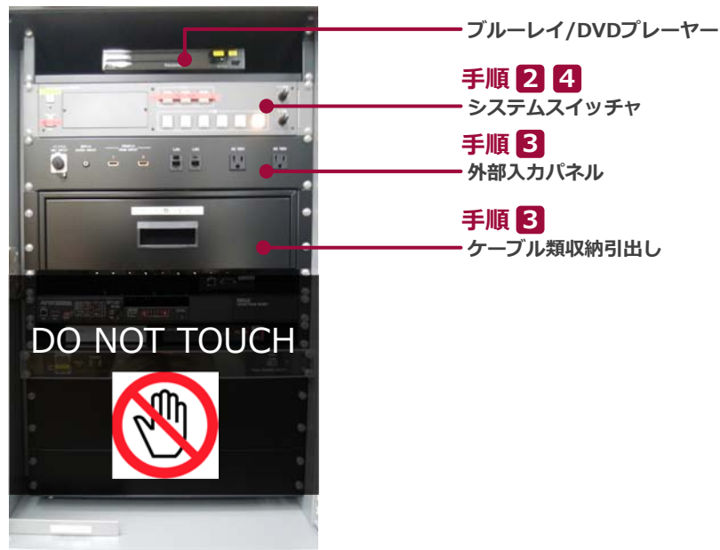
AV操作ワゴン 内部
